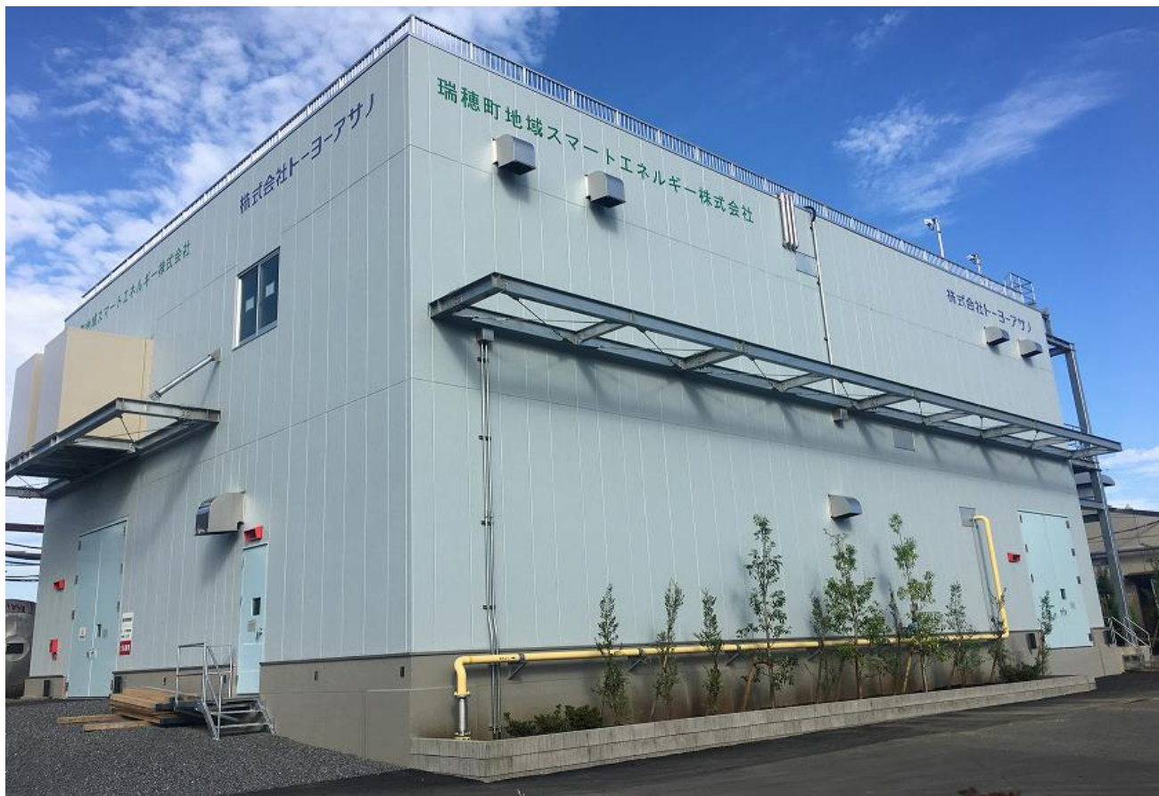
《スマートエネルギーセンター写真》
